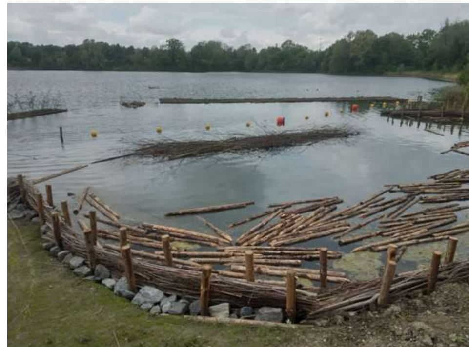
Unterwasser Zaun mit Verschiedenen Großen Öffnungen zum Fischdurchlass
